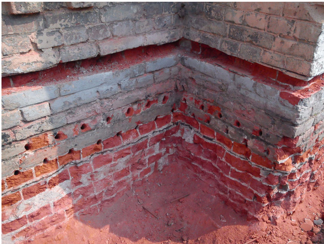
Рисунок 24. Вариант устройства гидроизоляции против капиллярного подсоса
